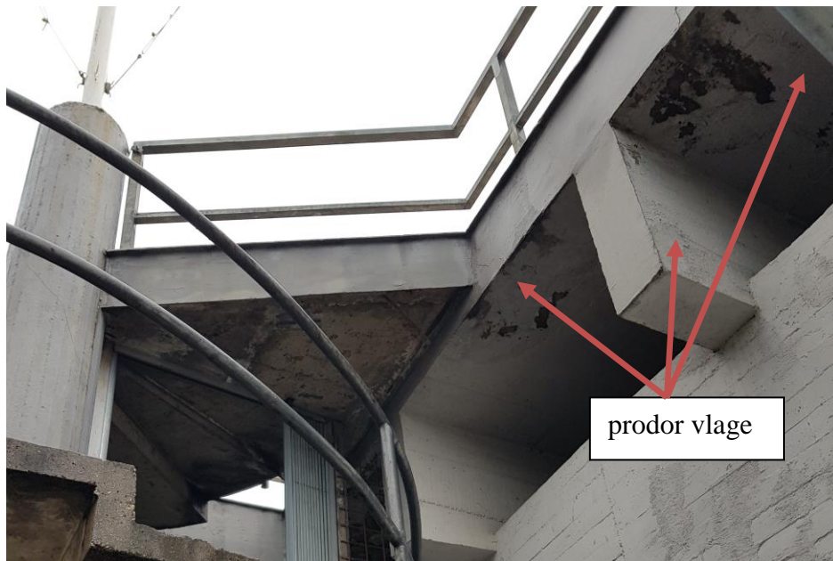
Fotografija br.13 : vlaženje i propadanje stropa iznad slobodnog prostora i spiralnih stepenica
