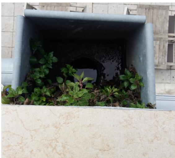
Fotografija br.6 i 7 : vidljiva vegetacija na dijelu izvoda oborinske odvodnje i neuredni detalji Iznad vertikale odvodnje
