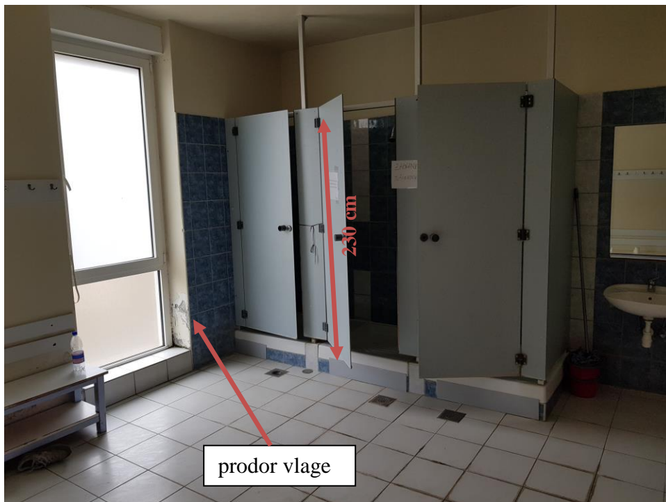
Fotografija br.22 : prostor za tuširanje (vidljivi prodori vlage uz rubove stolarije)
