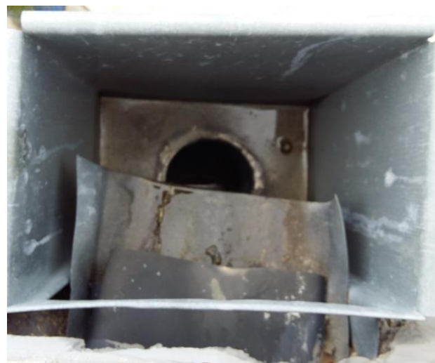
Fotografija br.6 i 7 : vidljiva vegetacija na dijelu izvoda oborinske odvodnje i neuredni detalji Iznad vertikale odvodnje
