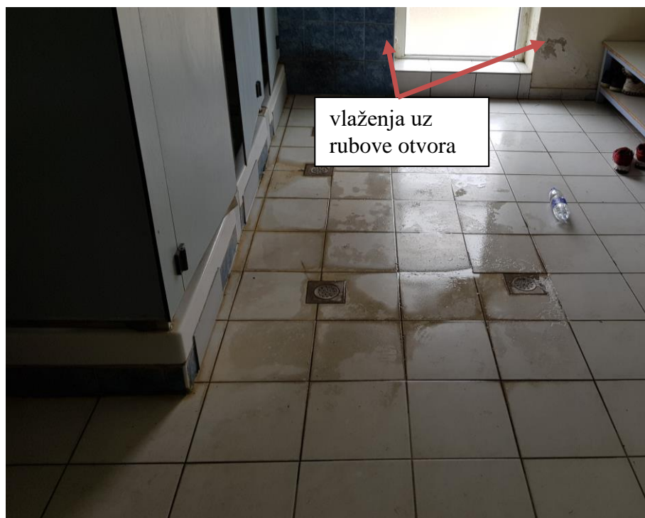
Fotografija br.19 : vidljiva vlaženja uz rubove stolarije
